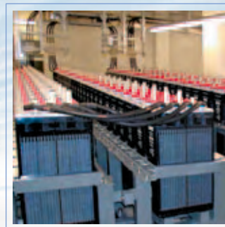
Рис. 17 Смонтированная батарея Classic OCSM
