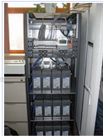
Рис. 15 Смонтированная батарея A412/120FT
